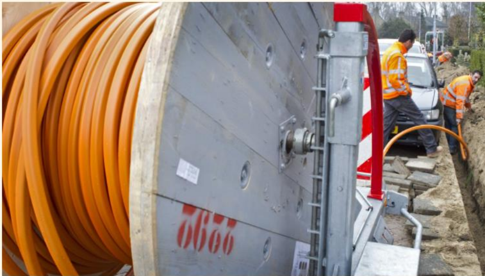
Het aanleggen van glasvezelkabel. Amadys is onder meer actief in de levering van componenten voor glasvezelnetwerken. ©ANP XTRA
